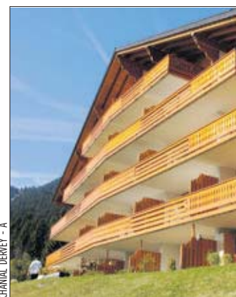
La zone de la Saussaz (ici la résidence du Balcon des Alpes), est en zone à risques. Elle a été déclarée non constructible.
